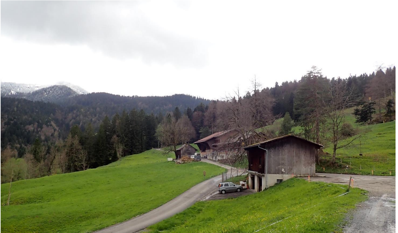
Abbildung 2: Ansicht auf die Ökonomiegebäude von der Alp Sonnegg aus. Der Milchviehstall wurde im Jahr 2015 teilweise saniert und mit einem Neubau ergänzt.
