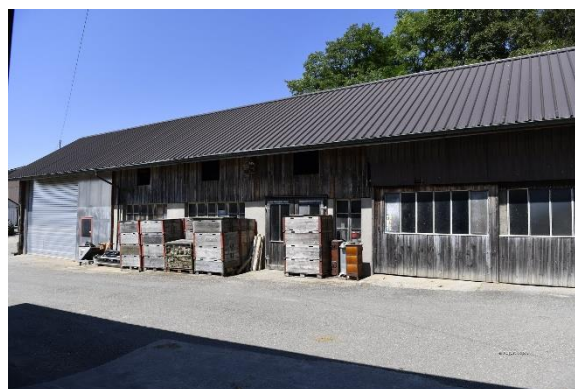
Werkstatt, Lagerräume, Garage
